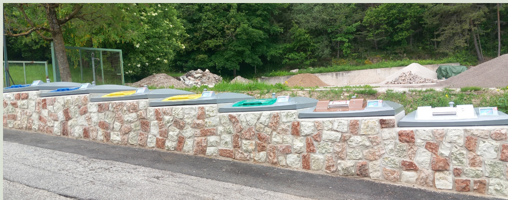
Foto 2 - Aus sieben teilversenkten Containern bestehende Abfallsammelstelle in der Gemeinde Fai della Paganella; die Struktur wurde von der Gesellschaft A.S.I.A. srl. aufgestellt
