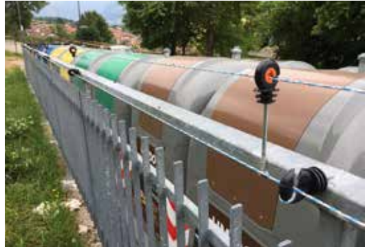
Foto 20 - Fai della Paganella: Dieselbe Abfallsammelstelle wie auf den vorangegangenen Fotos, die auf drei Seiten mit Metallbarrieren und stromführenden Drähten versehen wurde (M. Zeni – Archiv des Amtes für Fauna – Autonome Provinz Trient)
